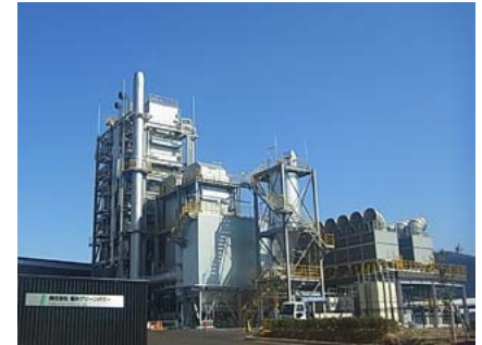
大野発電所全景
